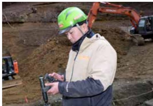
ICT機器を活用しながら効率よく作業を進めています
